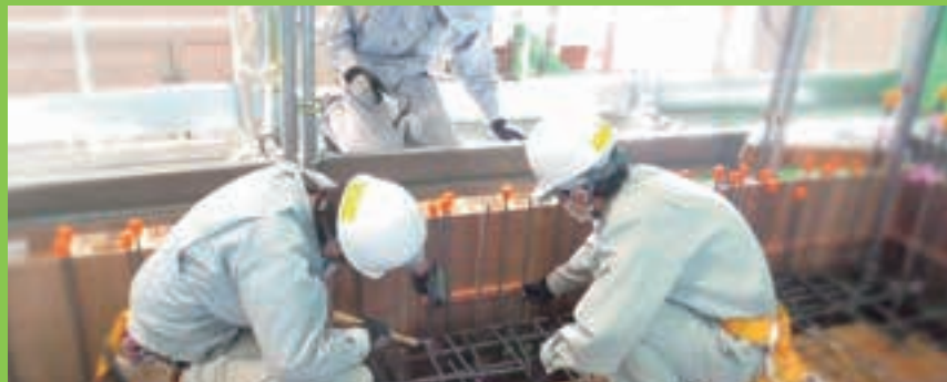
鉄筋コンクリート構造施工・施工管理課題実習
