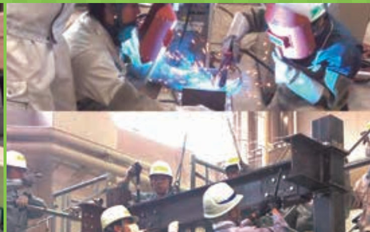
鋼構造（鉄骨造）施工・施工管理課題実習
