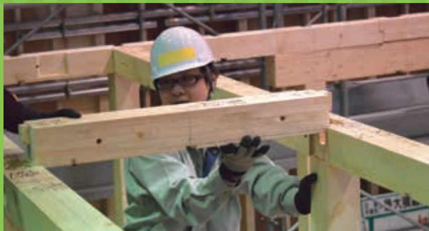
木質構造施工・施工管理課題実習
