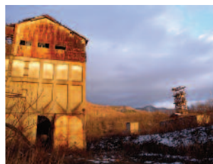
図3 積込ポケットと立坑櫓
