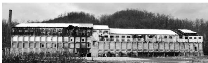
図5 積込ポケット南面現況
